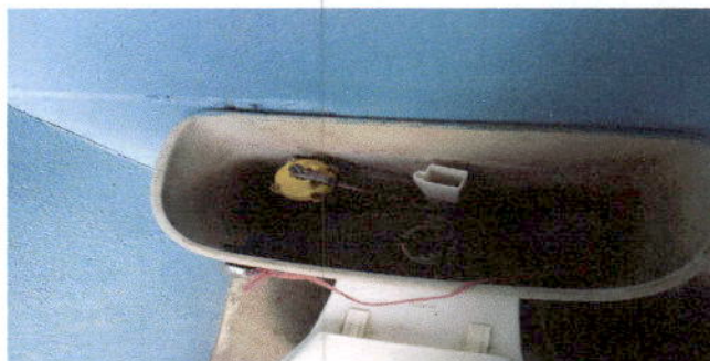
Foto 2: Sustitución de inodoro en el área de servicios sanitarios
